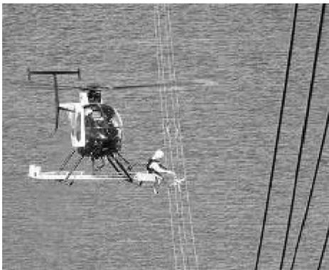
图 1-4 用直升飞机进行带电更换线路间隔棒
