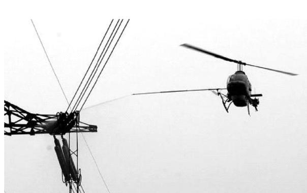
图 1-5 ±500kV 江城线带电水冲洗
