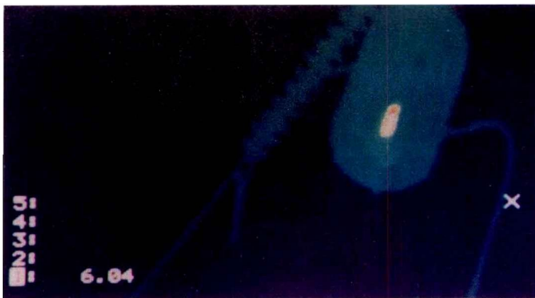
图H39 阻波器内避雷器损坏
