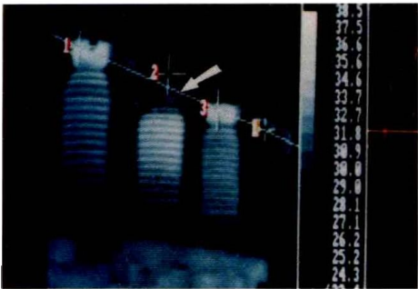
图 H17 110kV 电压互感器缺油
