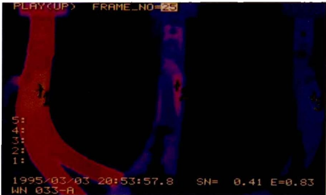
图 H22 电缆头 接头接触不良
