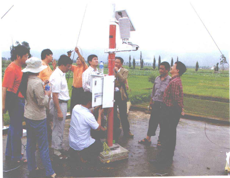
图 0.9 玉溪市气象科技人员在安装乡镇自动气象站
