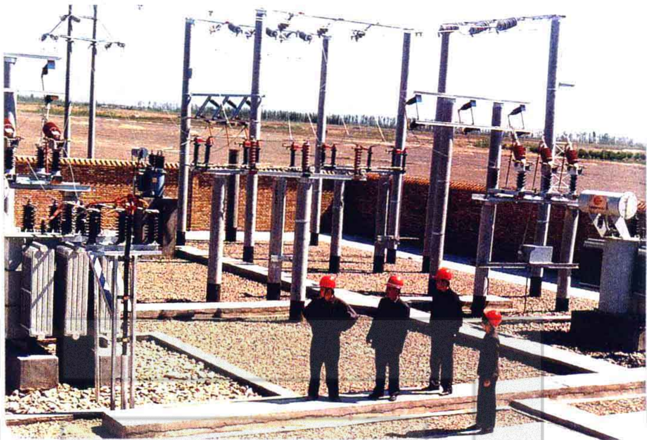
农网改造工程
