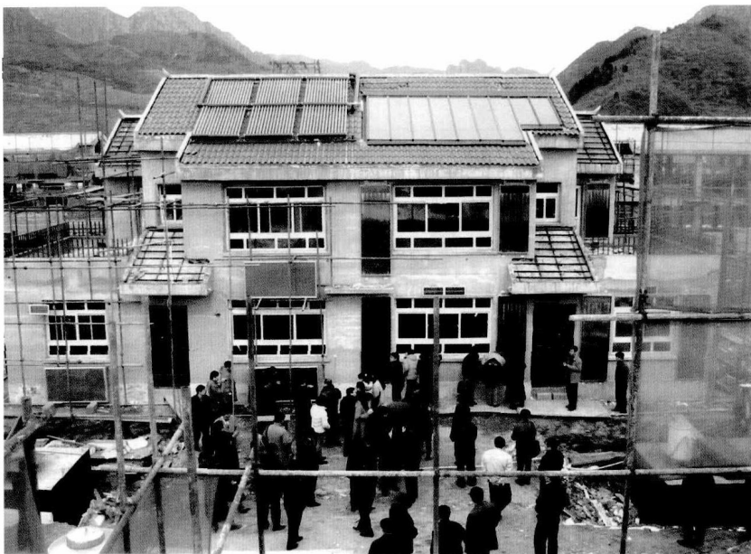
图 0-5 住宅热工性能和太阳能供热系统热性能对比实验
