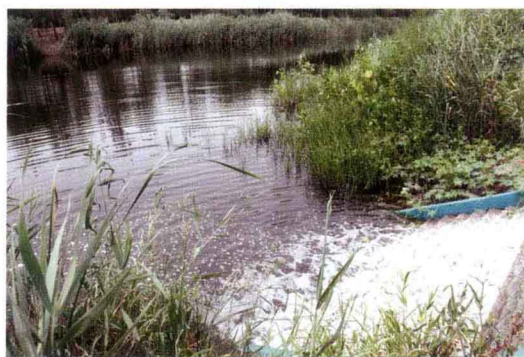
空港湿地工程出水
