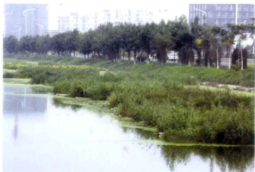
外环河沉床全景
