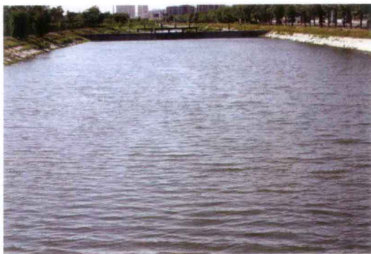
外环河修复段下游水景
