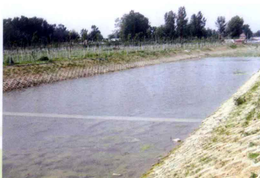
刘相营污水处理工程出水
