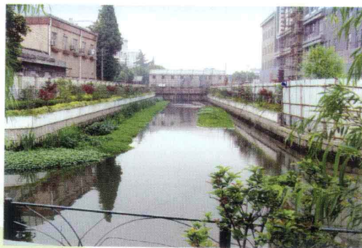
三友河治理工程出水
