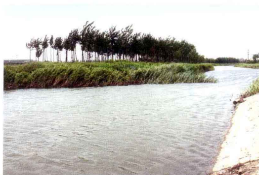
空港河道治理后景观
