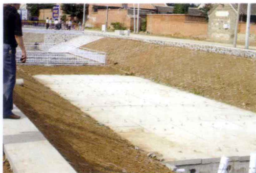
刘相营污水处理生物滤池
