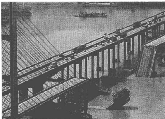
图2 “6·15”九江大桥船撞桥梁事故场景
