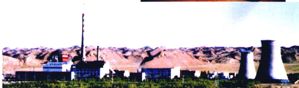
塔城地区铁厂沟发电厂（总装机7.4万千瓦）
