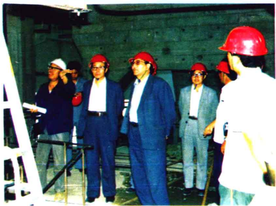
1988年8月26日，塔城地委书记李逢滋（左二）、行署专员阿尔斯坦别克（中）在铁厂沟电厂查看一期工程建设的进展情况
