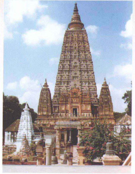
印度佛陀伽耶大塔
