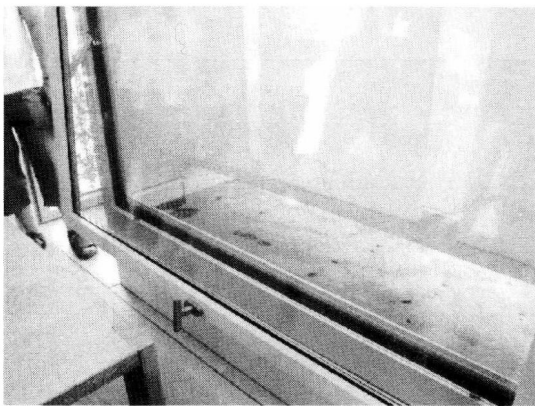
图 7 室内直接蒸发降温设备 (图片来源：作者自摄)
