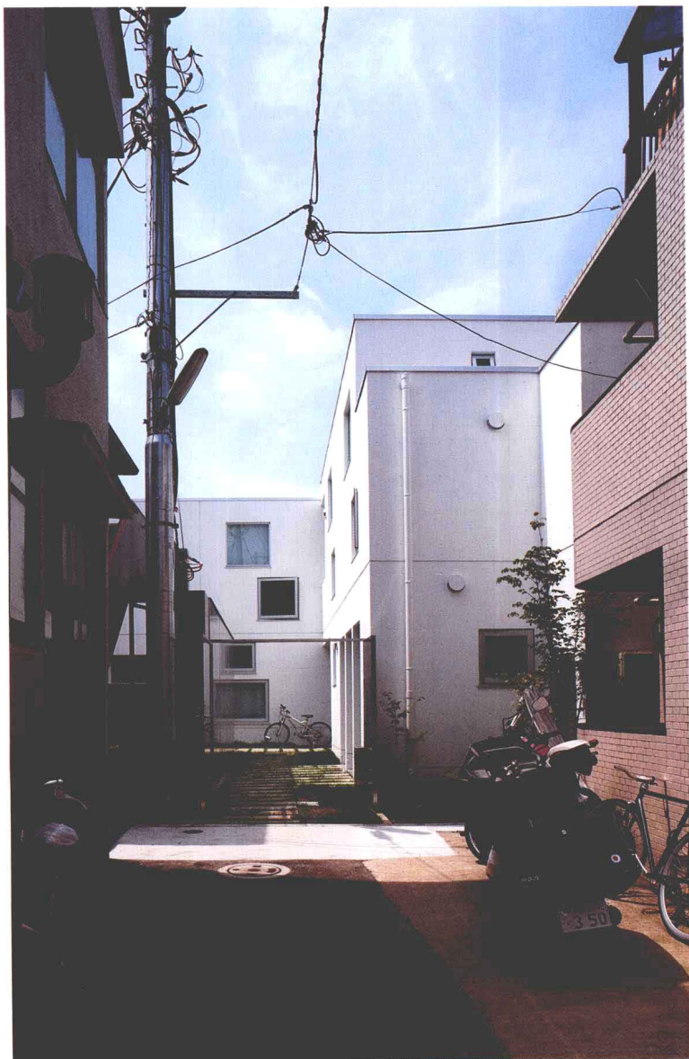
由北侧的道路眺望。道路上停放着居民的自行车等，形成了连续的地面空间。
