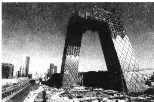
图 1-7 施工中的北京中国中央电视台新大楼
