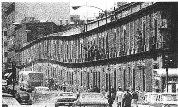
图0-4 墨西哥城一幢建筑的不均匀沉降
