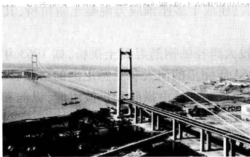
图 0-1-3 润扬长江公路大桥
