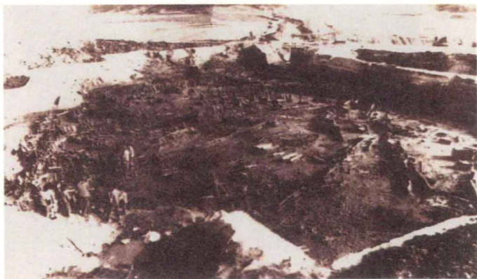
河姆渡遗址发掘现场 ▶
