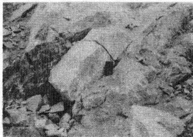
图 1.4 永久船闸边坡岩体结构
