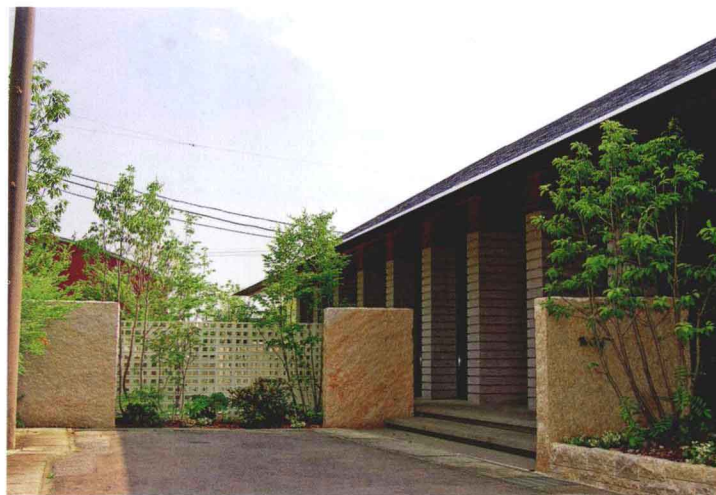
① 与之前施工的室外设施相结合，表面被分割过的复古御影石壁和留出空隙的砖头作为北门入口（北侧）的装饰。
