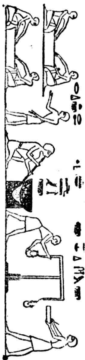
圖 1. 古代埃及金的精鍊（壁畫）：洗取砂金，鑄副金屬，秤量金屬。
