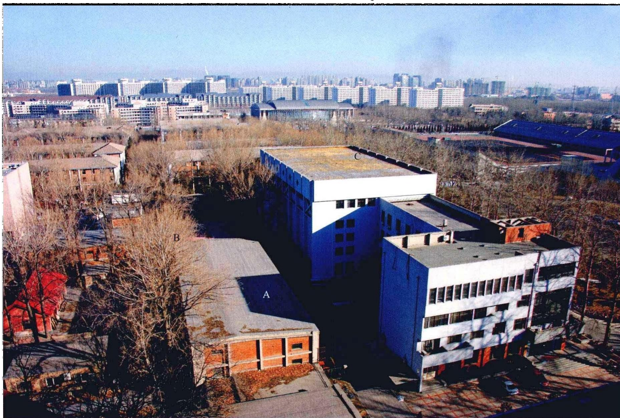
工程结构实验室鸟瞰图 A 结构试验厅(1), B 结构试验厅(2), C 大型结构试验厅
