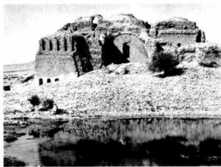
2.1-9 浮伊鲁札巴德宫殿，公元 3 世纪，沙桑王朝初代建造。面宽 56 米，进深 104 米，粗石砌筑。
