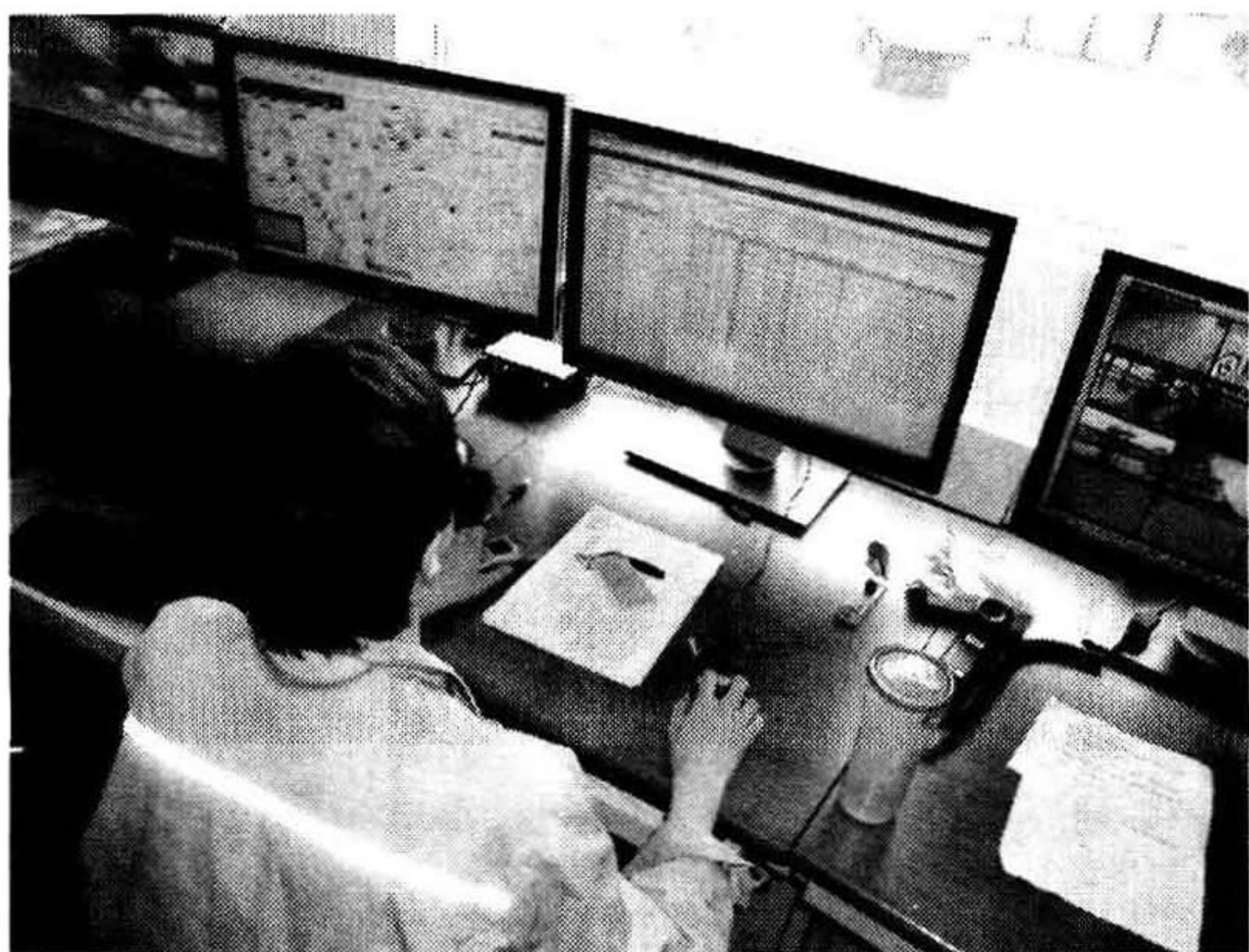
图 1-4 集运系统中控室
