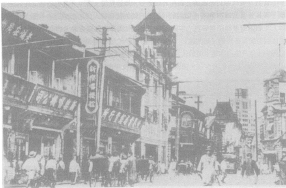
望平街的南端（山東路福州路的轉角）能見後建的《時報》館寶塔式樓，異常觸目
