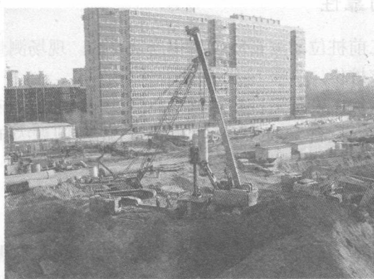
图3 钢护筒逐节压进后的钻孔施工
