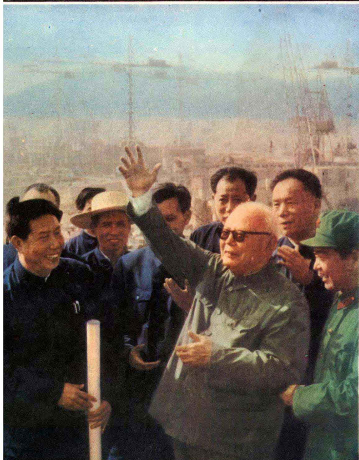
◀ 1979年4月19日，叶剑英同志在葛洲坝水利枢纽工程工地
