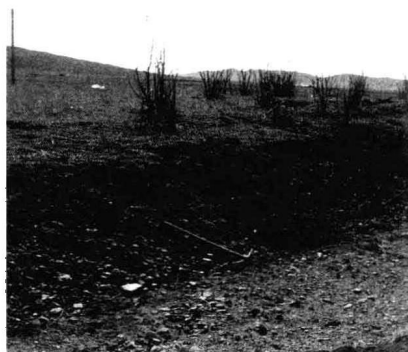
图 1.5 绿化施工破坏边坡
