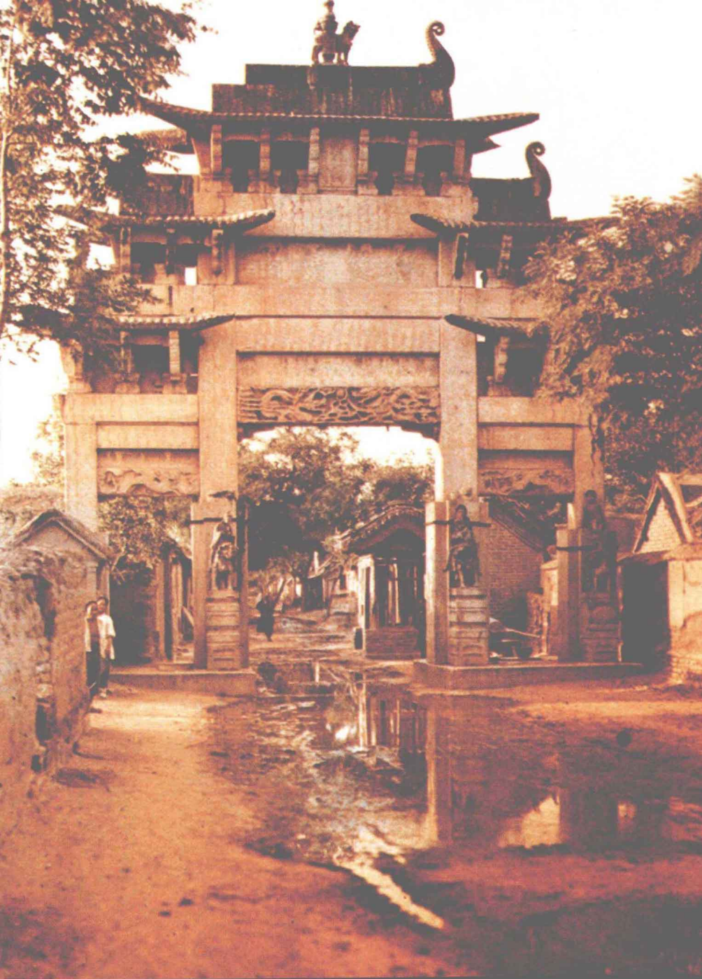
山东曲阜孔庙西半壁街石牌坊
