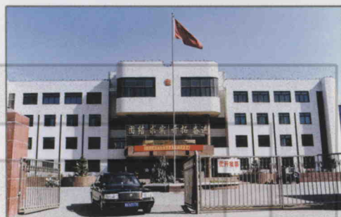
乌鲁木齐县七道湾乡政府办公大楼
