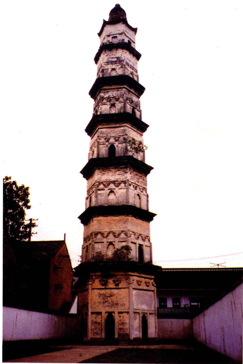
大珠慧海禪師的道場（浙江省紹興大雲寺 按：今寺已廢，僅存寺塔）
