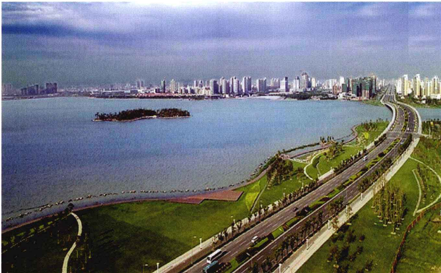
苏州地铁金鸡湖区间风亭人工岛
