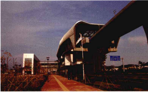
武汉轨道交通1号线高架站
