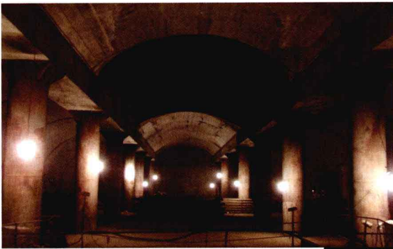
广州地铁 = 区庄站暗挖三联拱结构
