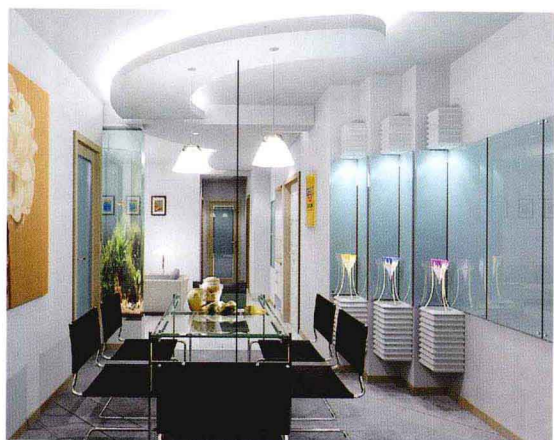
石膏板造型吊顶
