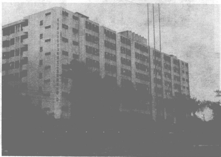
图1 广州NHX街工业区员工宿舍大楼
