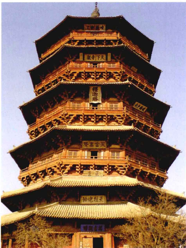
图2-1-4 山西应县木塔
