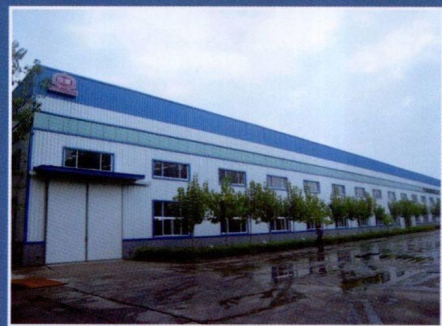
新建现代化车间
