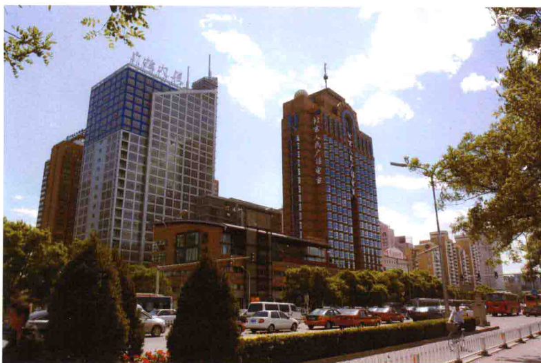
启用的北京人民广播电台办公大楼及正式启用的北京广播大厦。
