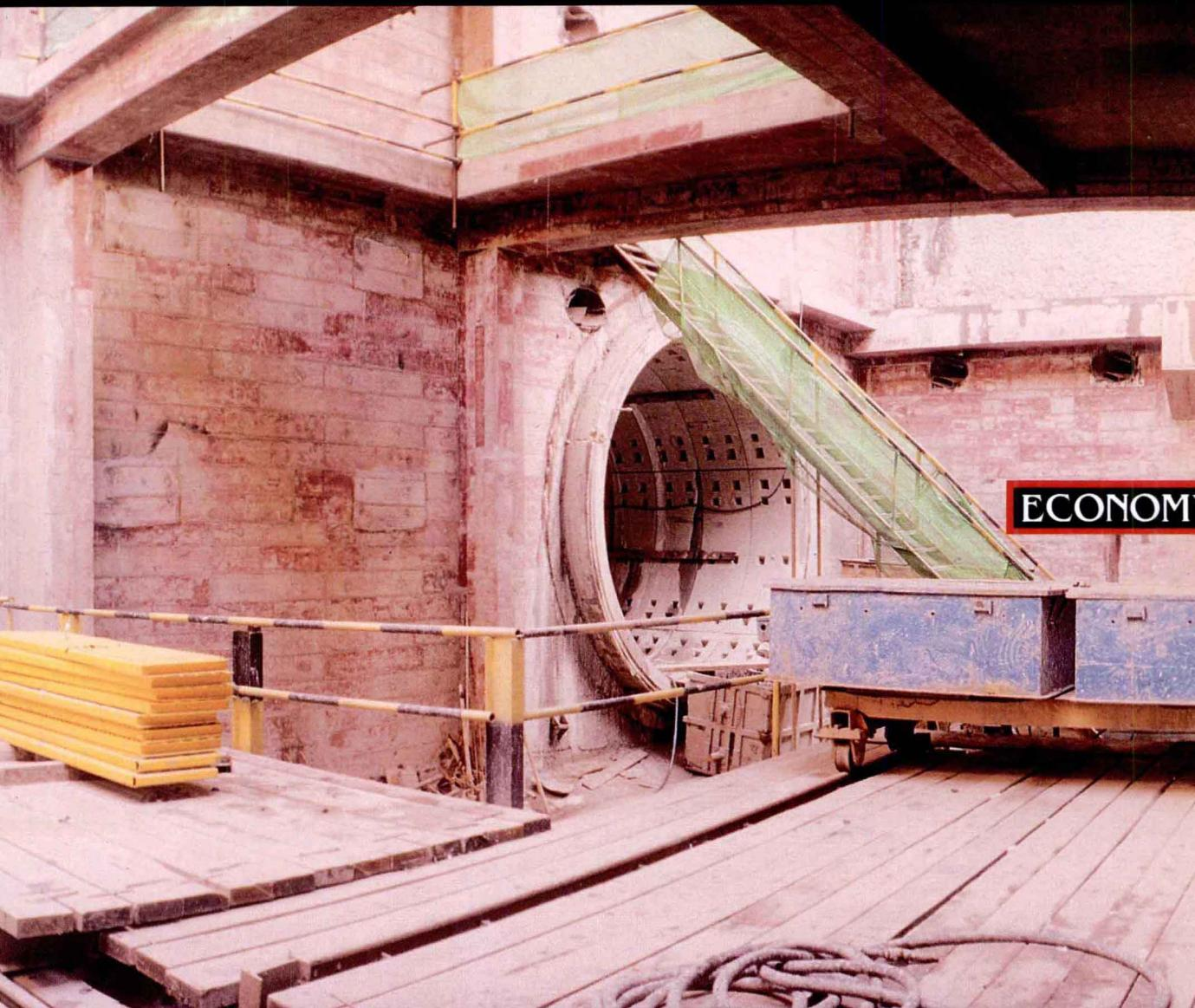
东方路至东昌路区间隧道 外径6.2米、内径5.5米
