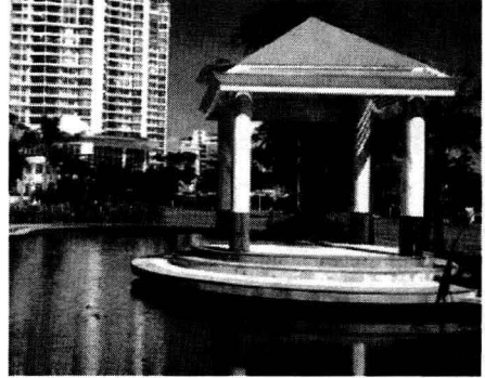
图2-10 钢筋混凝土景观亭
