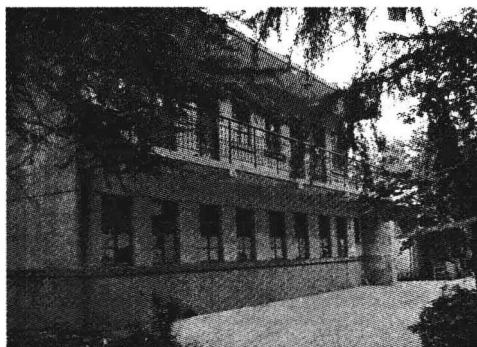
图6 特种焊接材料研究室旧址
