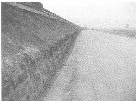
图 1-1 边坡削坡
