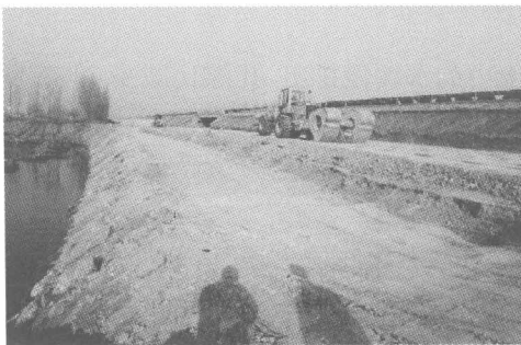
图 1-4 冲击压实施工
