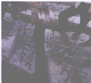
▲ 预留孔洞尺寸错误，预埋筋位置错误
