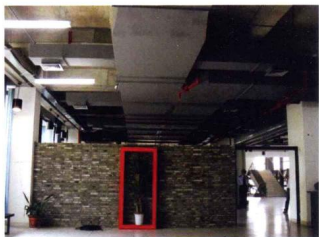
图2-5 某大学图书馆实景
