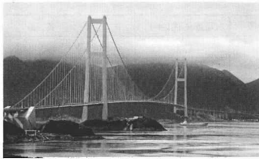
图 1.2-8 舟山西堠门大桥
