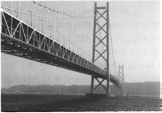
图 1. 2-4 日本明石海峡桥
