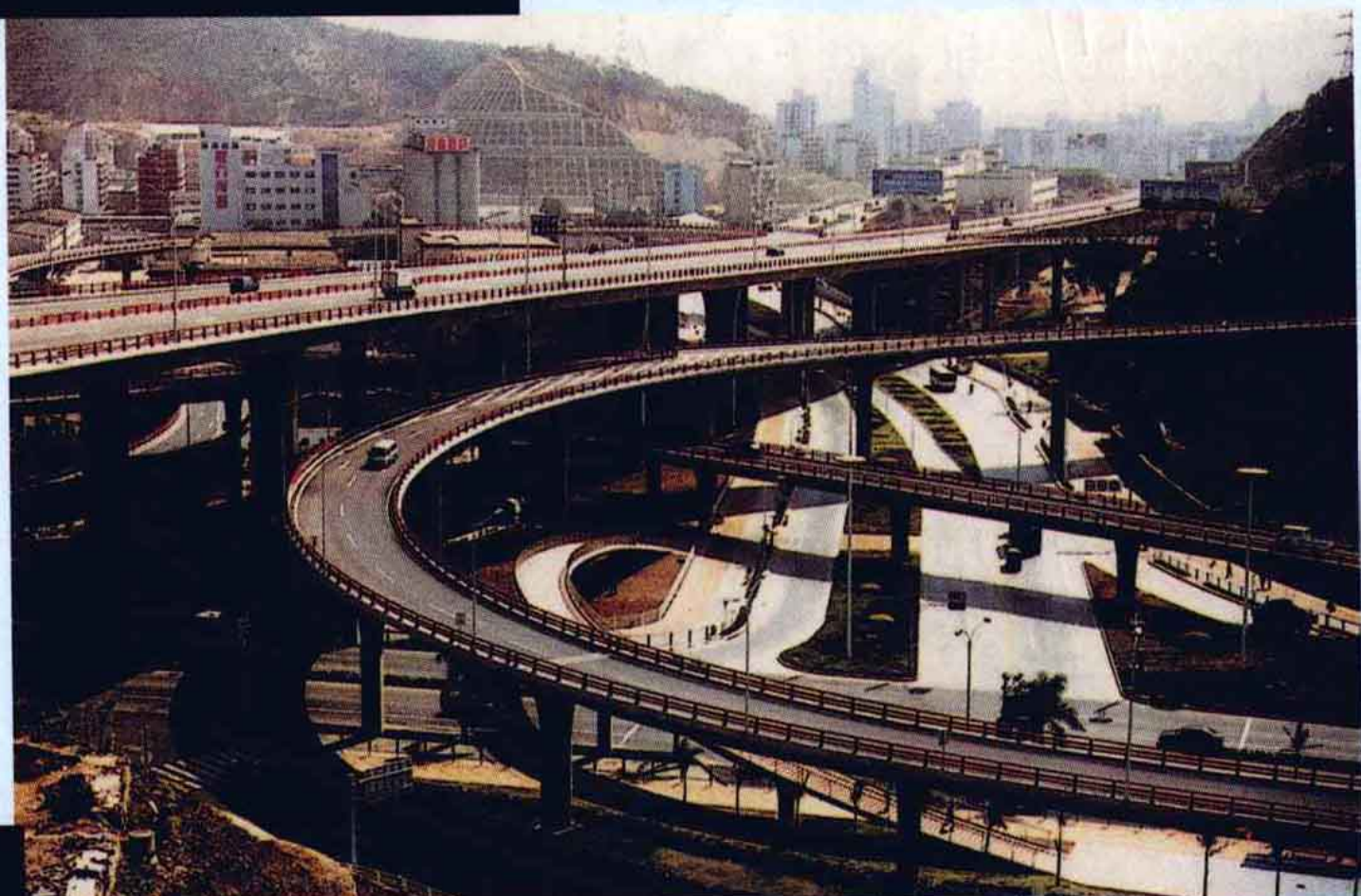
厦门海沧大桥引桥
