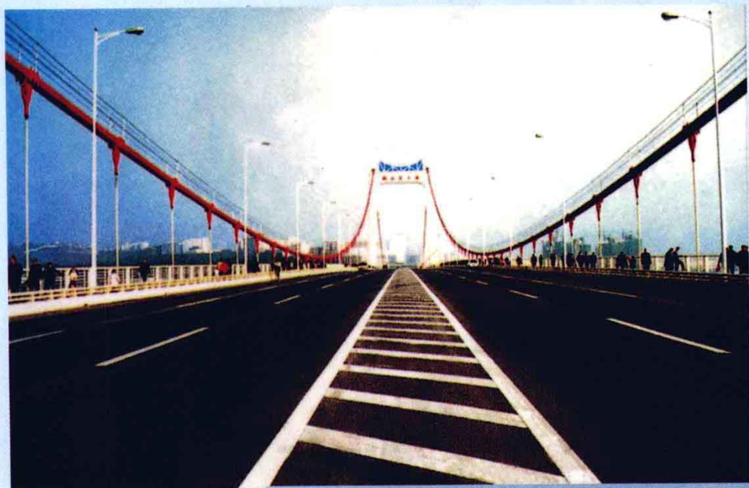
重庆鹅公岩大 桥钢桥面铺装
