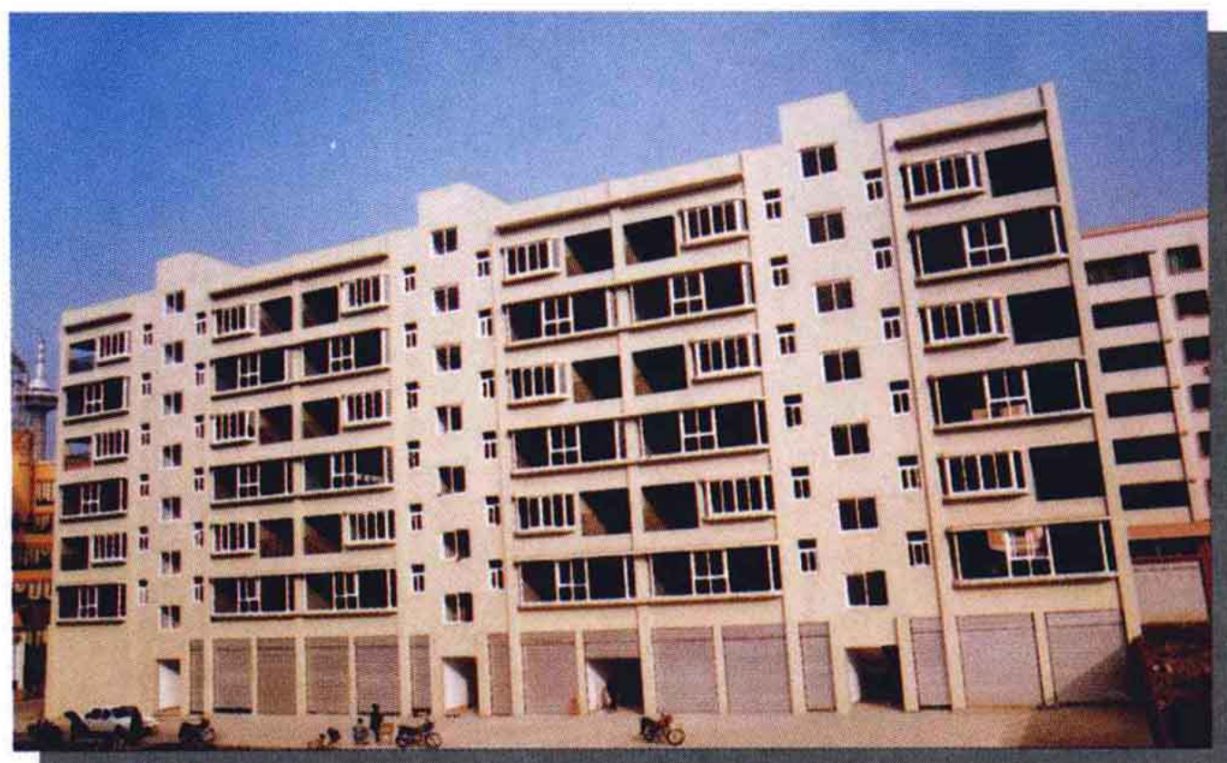
重庆市银泉实业有限公司用国际先进技术生产的塑料型材门窗安装在新建房屋上
