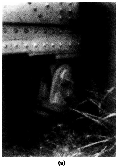
图 1.11 活动铰支座 (a) 桥梁活动铰支座; (b) 辊轴支座; (c) 摇轴支座; (d) 活动铰支座计算简图
