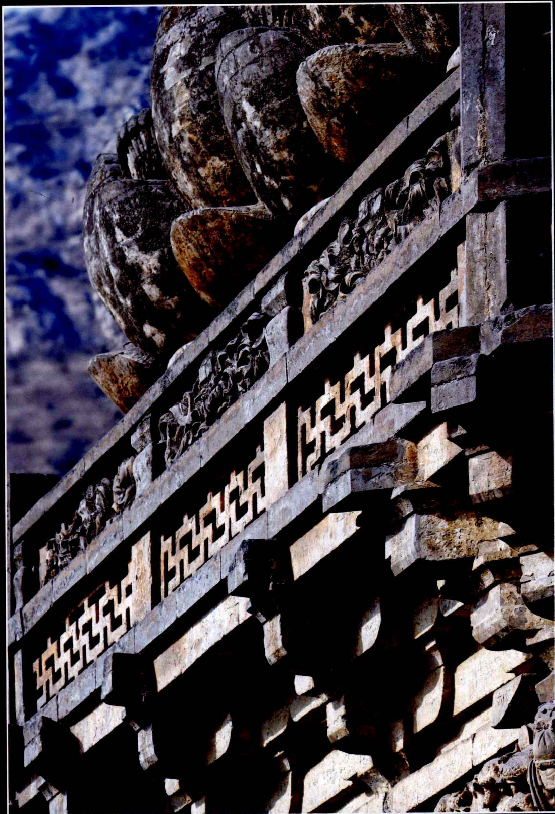
山西灵丘县觉山寺之基座,此塔为辽代砖塔的经典之作。(陈鹤摄)
