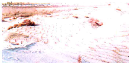
网格化固沙工程
