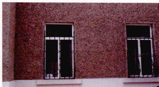
图14 细卵石墙面 Fig.14 Pea pebble wall
