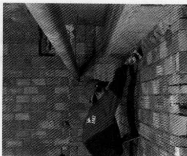
图 1-14 水平拉线，补做中间灰饼，间距 1.5m
