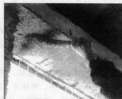
图 1-9 加气混凝土基层洒水刷界面剂后抹水泥混合砂浆
