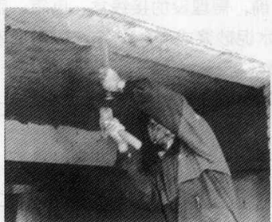
图 1-10 混凝土基层毛化处理
