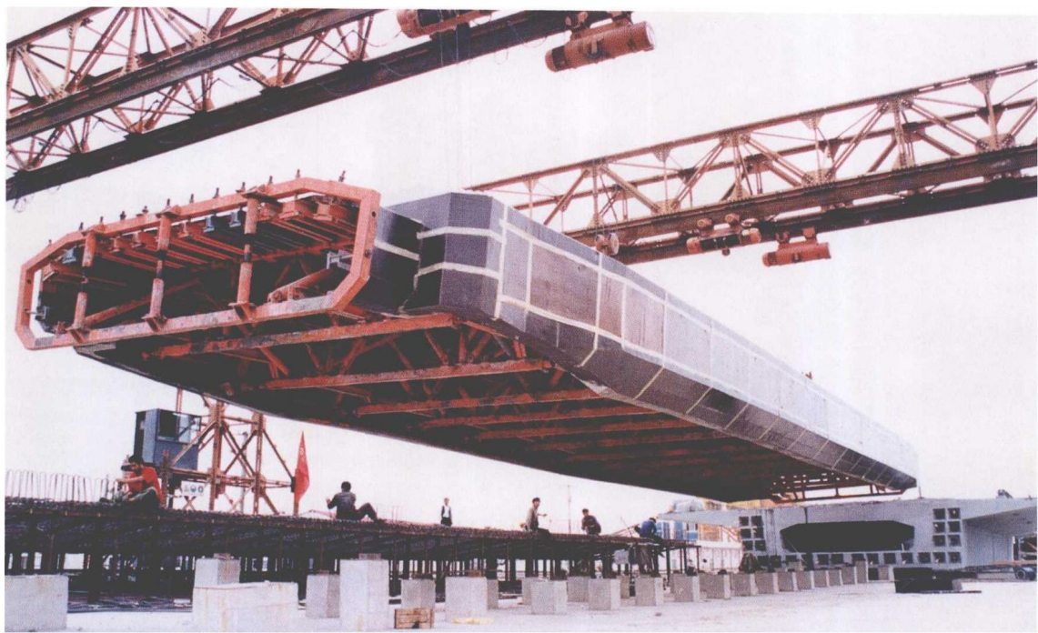
中铁大桥局箱梁制造
