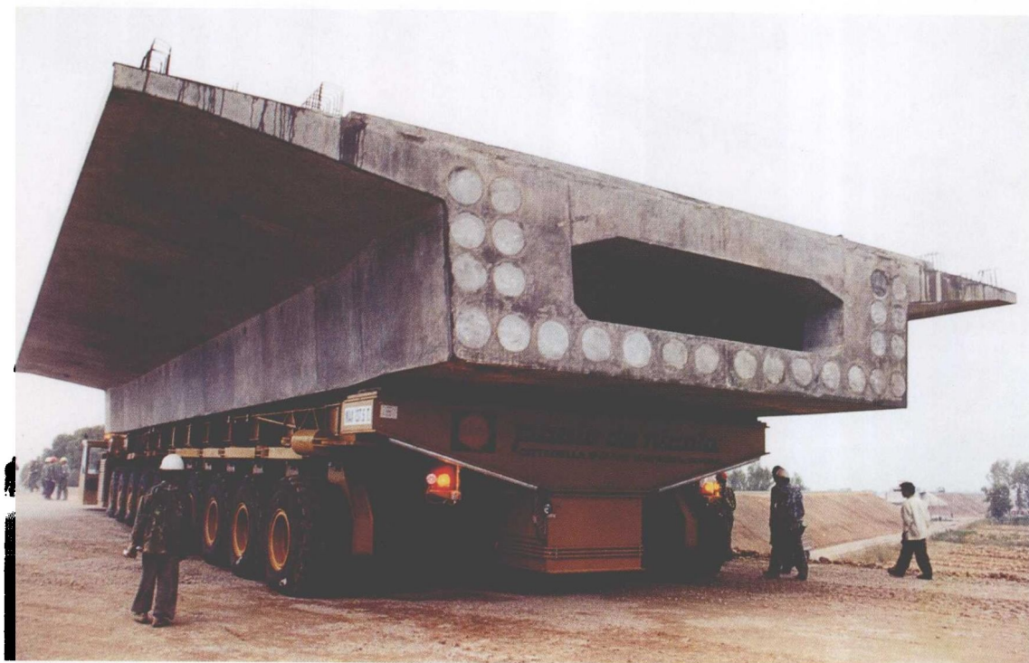
中铁二局运梁车
