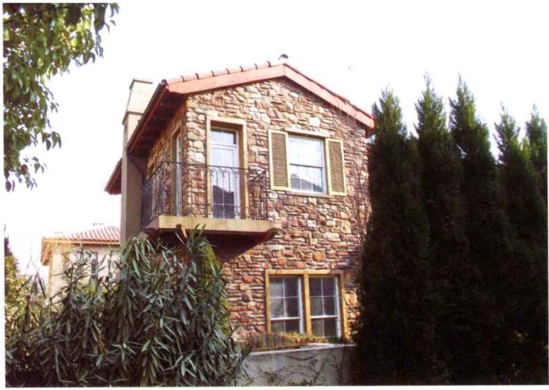
项目建筑外墙使用彩色水泥抹灰墙面结合特殊材质的墙砖及石材。彩色水泥抹灰墙面 (STUCCO) , 具有特殊效果的经过拉毛工艺处理的外墙涂料, 分为细拉毛和粗拉毛, 依从自然的做法, 忠实还原建筑质朴的风貌。
