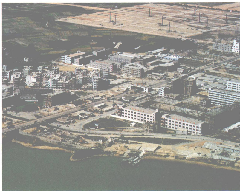
正在建设中的石碣镇新城区
